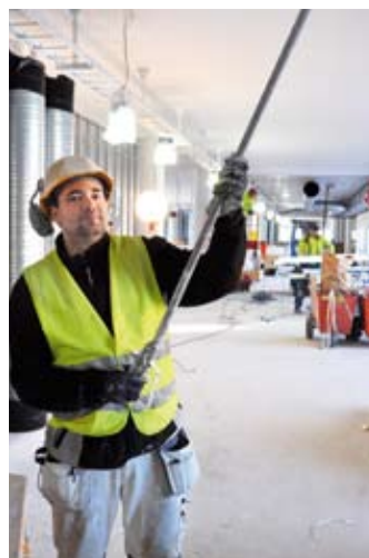
▲ Michael Ramström sprutmålar i en av lokalerna som ska bli bibliotek.
