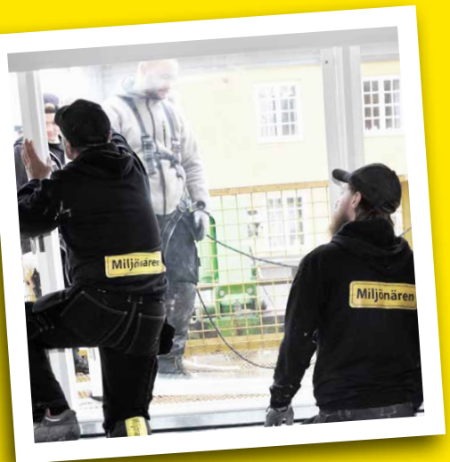
Här renoveras Stora Enso-fönstren så att de blir som nya.
